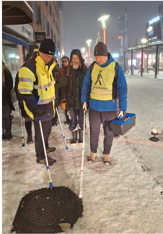
Kuva 4. Etualalla kuvassa näkyy lämmitetty hulevesikaivo, kuvan oikeassa reunassa ritilällä suojattu sadevesiputki.
